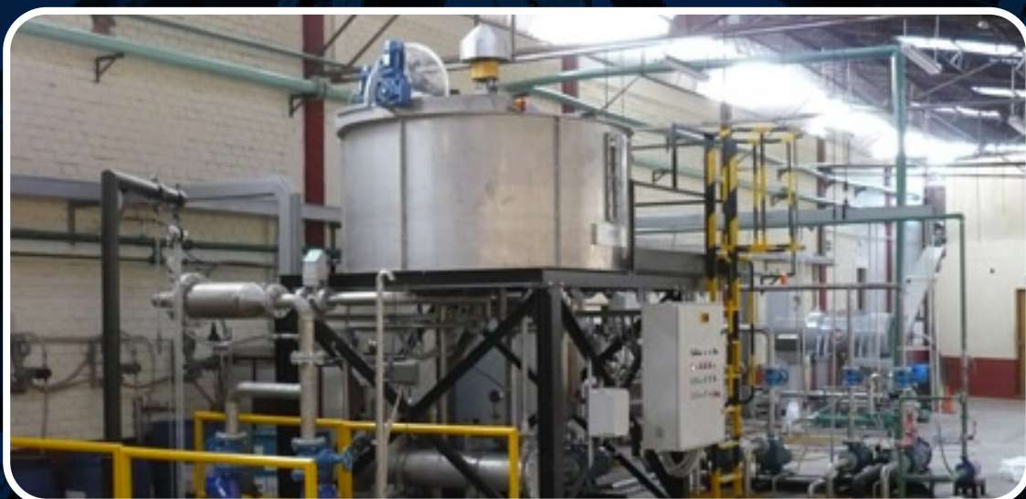
MONTAJE DE EQUIPOS
